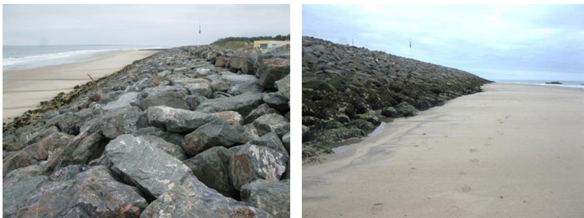
Fig. 3. Digue de l'Amélie (source ARTELIA septembre 2013)
