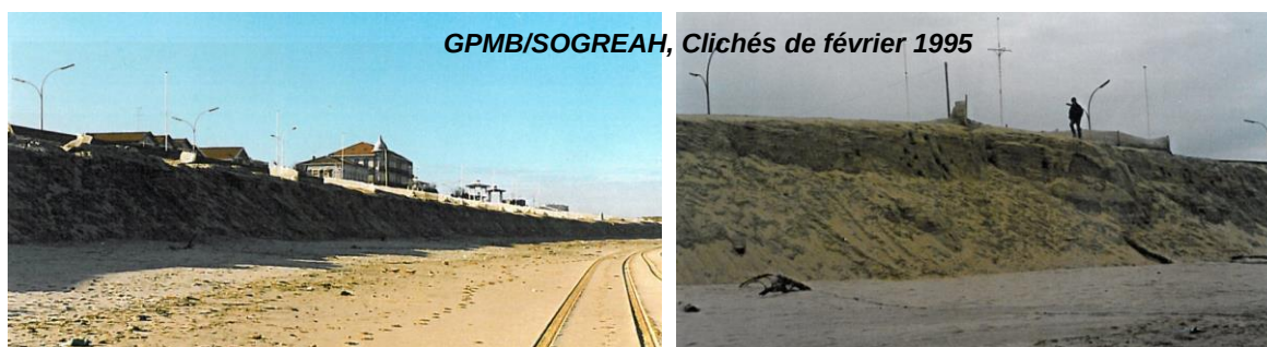
Fig. 46. Vues de la partie nord de la plage centrale de Soulac-sur-Mer en 1995 (source clichés : GPMB/SOGREAH)
