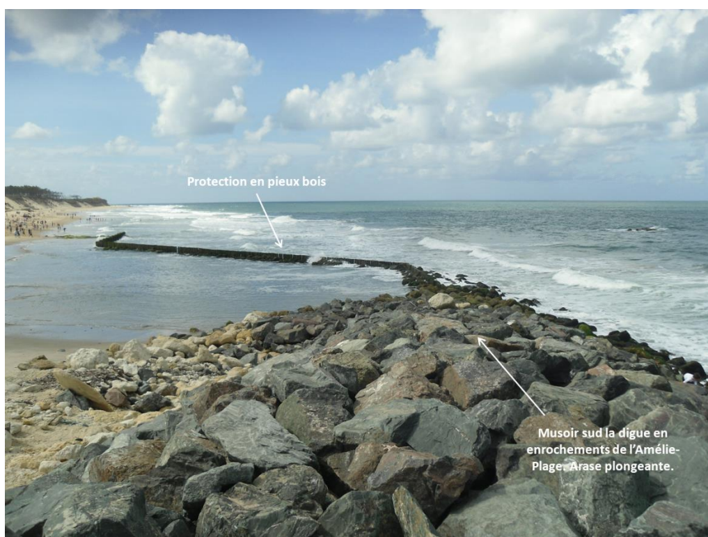
Fig. 79. Vue de la partie sud de la digue de l'Amélie-Plage depuis la digue. Section en enrochements et prolongement par pieux bois (photographie ARTELIA, 2011)
