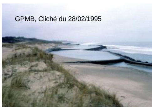
Fig. 54. Brise-mers des Arros aux Huttes – Ouvrages dégagés ou partiellement enfouis sous le sable
