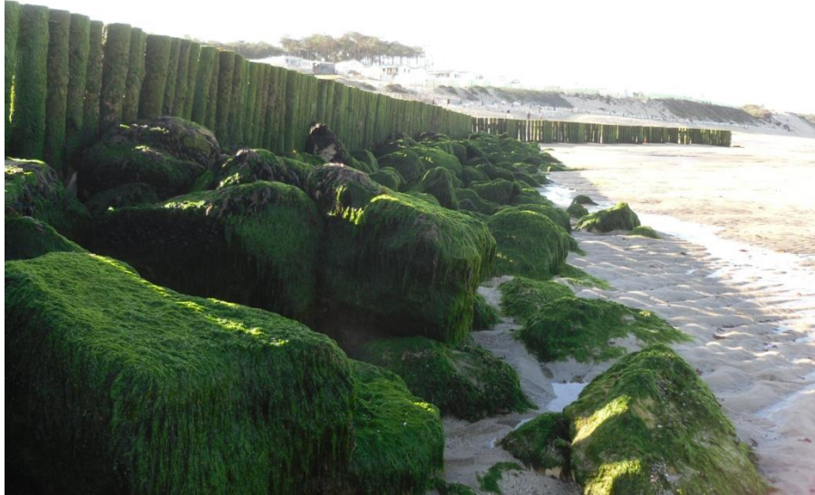
Fig. 25. Rangée de pieux bois dans la continuité sud de l'enrochement principal avec des enrochements de stabilisation posés en pied (source : ARTELIA 10/08/2011)
