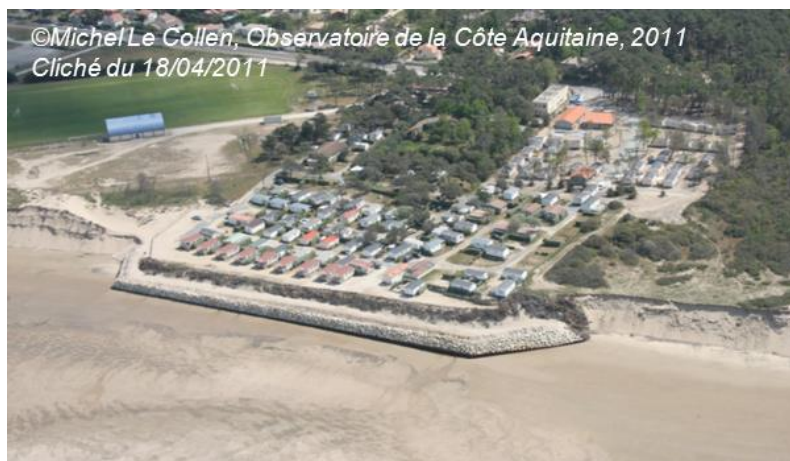
Fig. 10. Protection en enrochements du camping Les Sables d'Argent Front de mer de Soulac-sur-Mer
