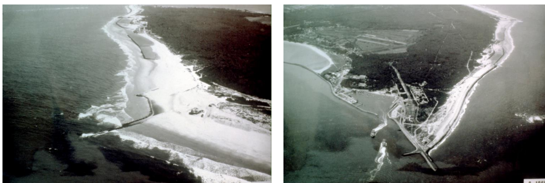
Fig. 61. Vues aériennes (1965) des ouvrages de protection du littoral entre la jetée de Grave et l'épi Saint-Nicolas (source clichés : Le Collen/GPMB, rapport MIACA)
