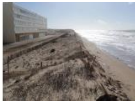
Fig. 39. Recul important face au bâtiment « Le Signal » (source : Commune de Soulac-sur-Mer, 2010)
