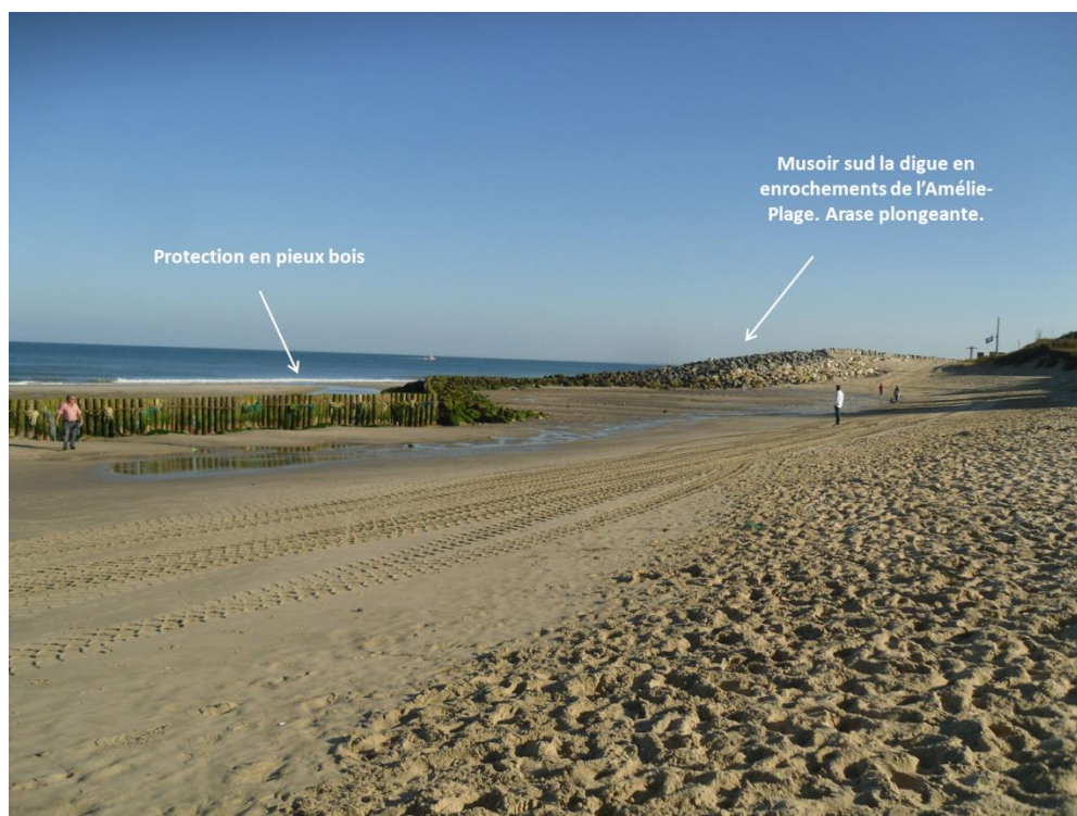
Fig. 80. Vue de la partie sud de la digue de l'Amélie-Plage depuis la plage. Section en enrochements et prolongement par pieux bois (photographie ARTELIA, 2011)
