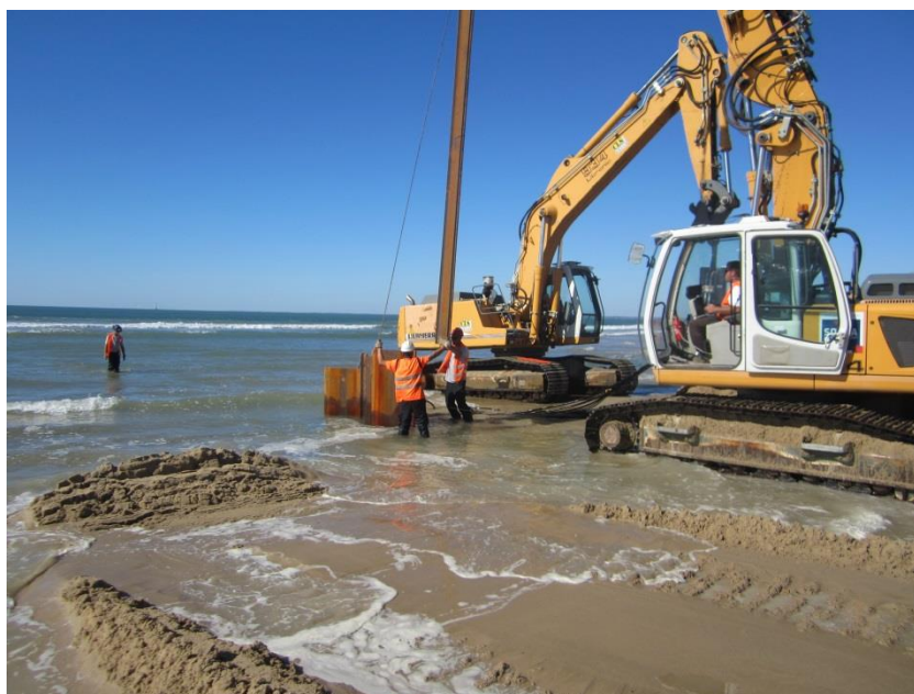
Fig. 16. Photographies des travaux du printemps 2014 sur l'épi Barriquand
