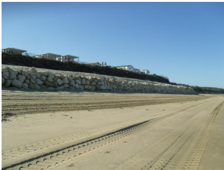
Fig. 34. Protection longitudinale en enrochements au droit du camping des Sables d'Argent (source : ARTELIA 10/08/2008)
