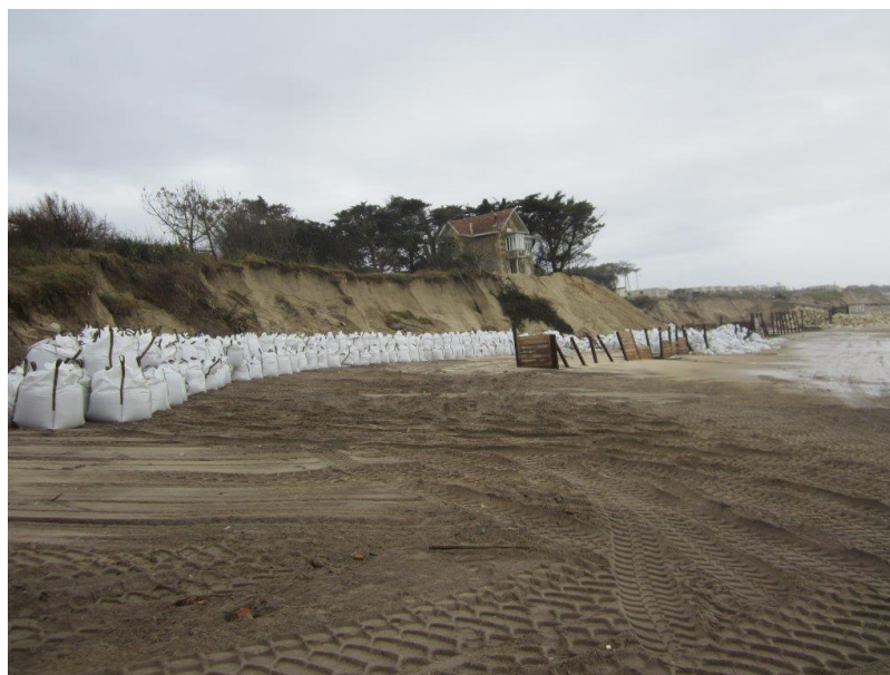
Fig. 7. Mise en place des sacs géotextiles remplis de sables en pied de dune durant l'hiver 2013/2014
