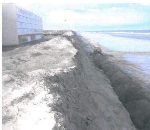
Fig. 40. Rechargement de plage devant le bâtiment « Le Signal » le 29/03/2010 (source cliché F. Ronzier, CCPM)
