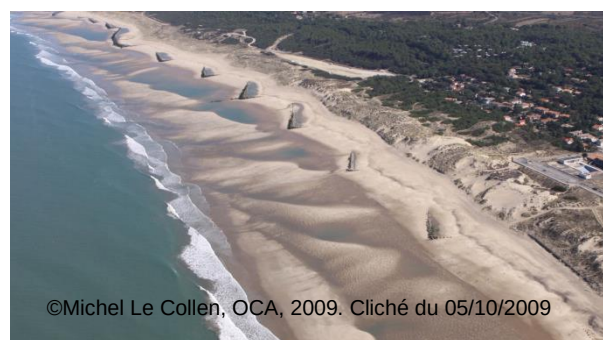
Fig. 54. Brise-mers des Arros aux Huttes – Ouvrages dégagés ou partiellement enfouis sous le sable
