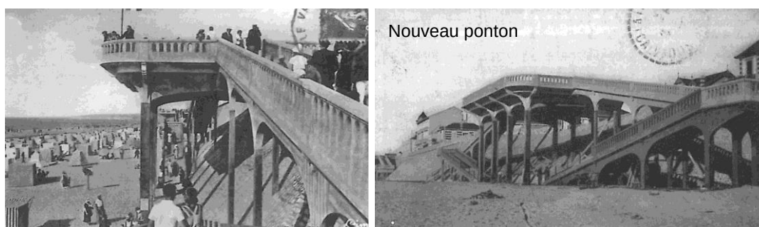
Fig. 44. Le second ponton de 1932 et son ensablement (source : Lescorce, 2009)
