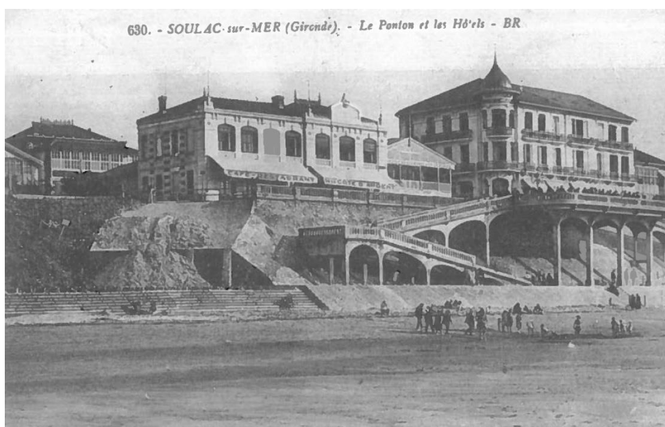
Fig. 11. Premier ponton ciment avec perré maçonné (source : J.P. Lescorce, Soulac-sur-Mer, la plage et les pontons)
