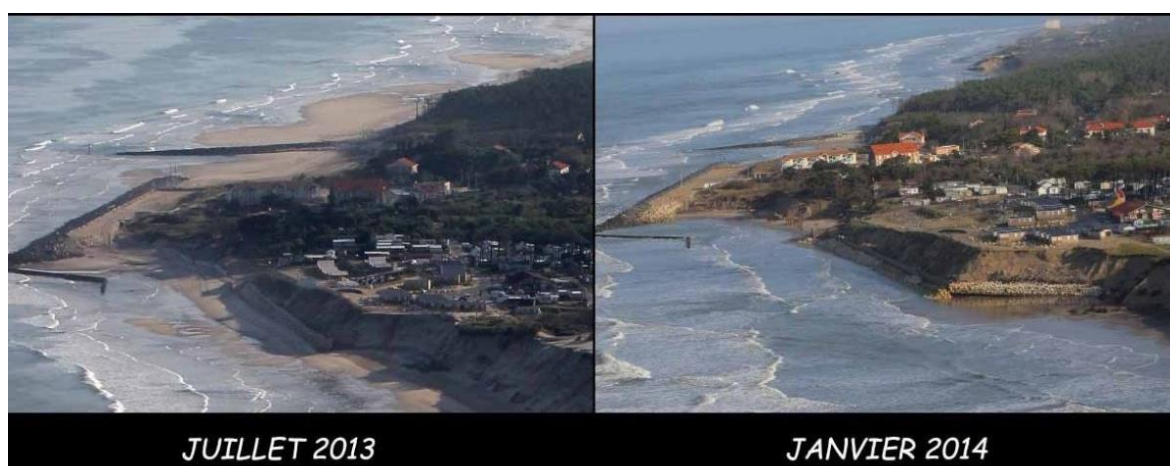
Fig. 2. Extension vers le sud de la protection en enrochements du camping l'Amélie-Plage au cours de l'automne 2013 (crédit photos sud-ouest)
