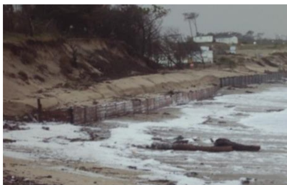
Fig. 6. Protection du pied de dune sud. Gauche : situation hivernal de 2010 (crédit photo CCPM 09/2010). Droite : situation estivale de 2011 (crédit photo ARTELIA 08/2011)
