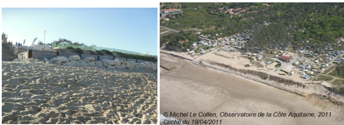
Fig. 1. Protection mixte madriers bois + enrochements au droit du camping l'Amélie-Plage
