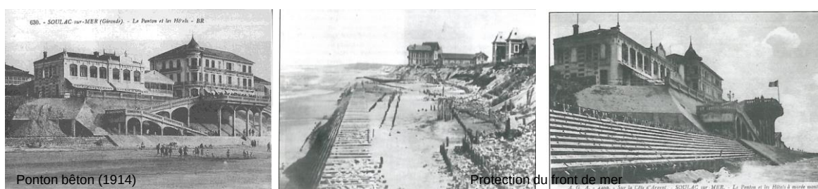
Fig. 43. Le premier ponton béton et la protection nord de 1914 – La nouvelle digue en bois de 1927 (source : Lescorce, 2009)
