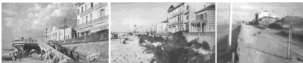
Fig. 45. L'engraissement de la plage et les atterrissements de sable sur le nouveau front de mer (source : Lescorpe, 2009)
