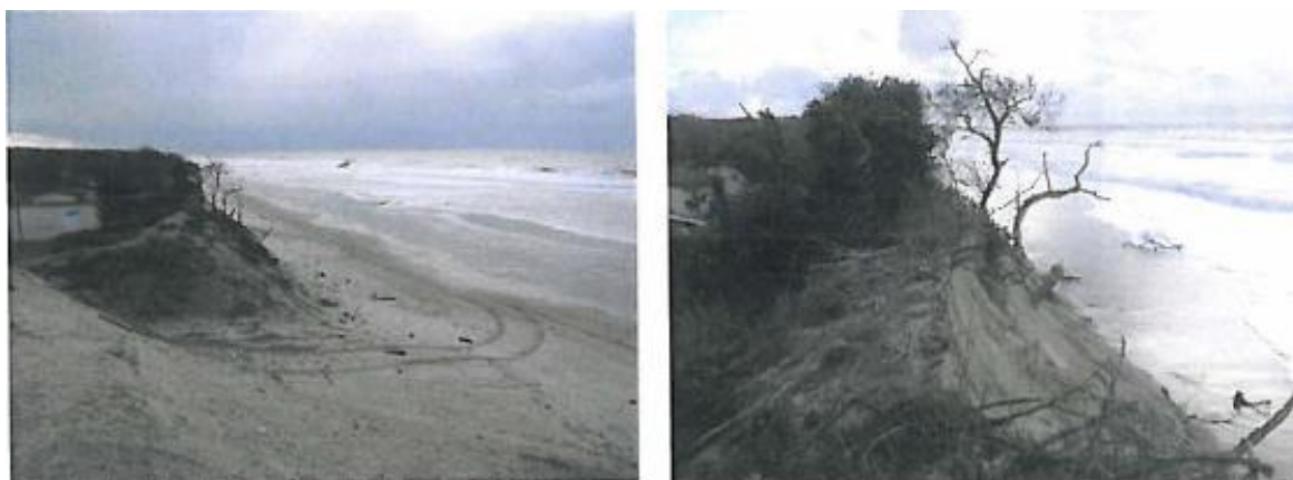
Fig. 35. Site du Crossa, vues vers le Sud. A gauche le 05/11/2009 (source cliché : J. Favennec, ONF), à droite le 10/02/2010 (source cliché : F. Ronzier, CCPM)
