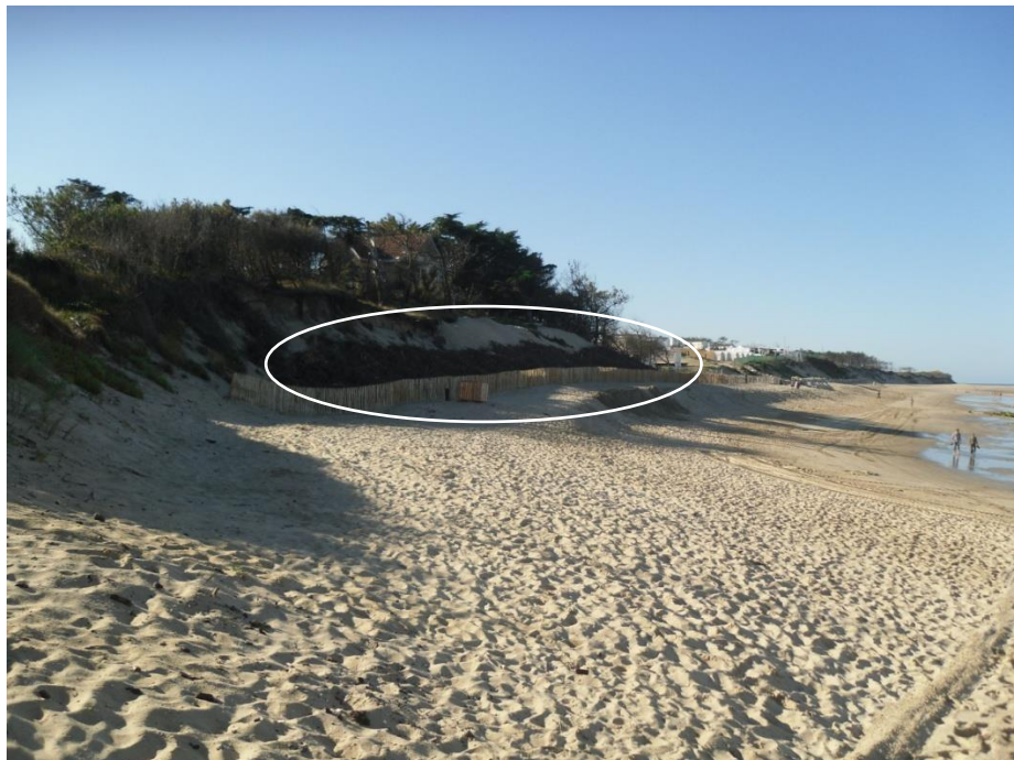
Fig. 26. Zone de la protection longitudinale au droit des villas (rideau vertical de madriers de bois tenus par des IPN) (source : ARTELIA 10/08/2011)
