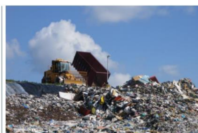
Centre de stockage à Naujac-sur-Mer
