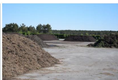
Plateforme de compostage à Naujac-sur-Mer
