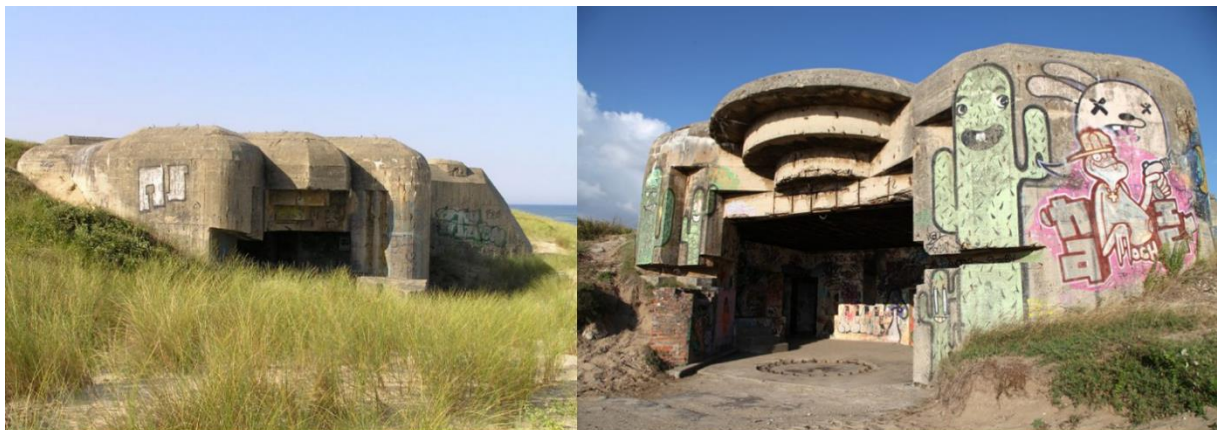
Bunkers du mur de l'Atlantique. Source : Gironde-tourisme
