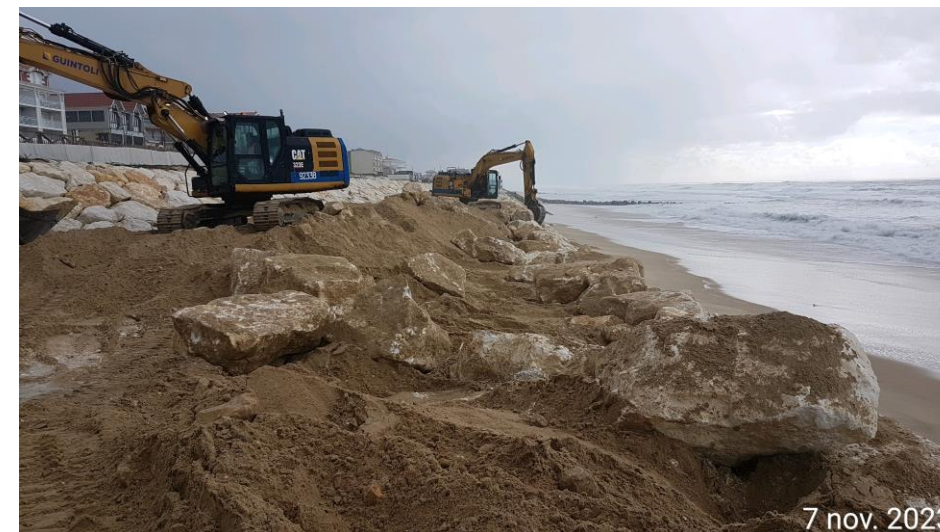
Travaux de reprise des désordres sur l'ouvrage en enrochements suite à la tempête Céline d'octobre 2023
