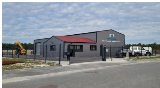
EURL ALEXIS ELOY Maçonnerie
